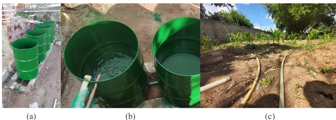
Figura 07. Sistema em operação: (a) - (b) captação de água de descarte e (c) irrigação da horta frutífera. (Fonte: autoria própria, 2022).
