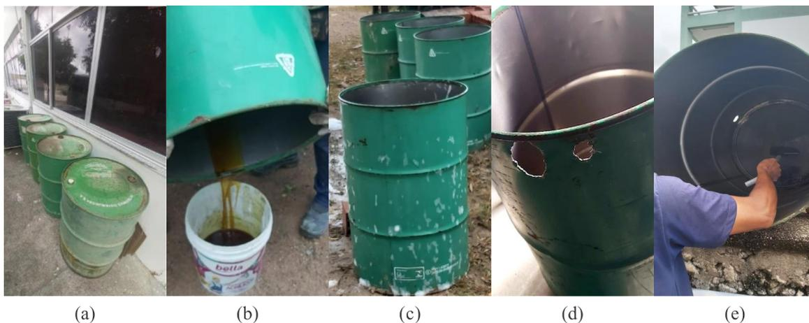
Figura 03. Construção do sistema de armazenamento: (a) recuperação dos tonéis (b) remoção de fluidos residuais, (c) limpeza, (d) perfuração e (e) pintura dos tonéis. (Fonte: autoria própria, 2022).
